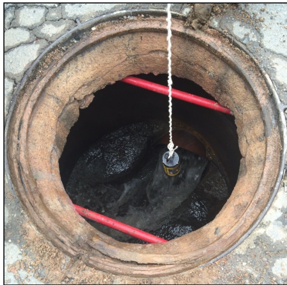
Figura 4: Medição de H 2 S dentro do PV antes da instalação da Coluna de CA.
